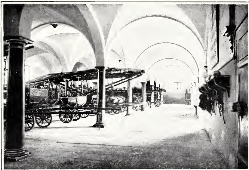
Fahrzeughalle des Feuerhauses in der Zeuggasse.
